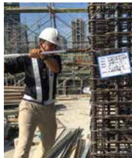
柱筋扭力測試
